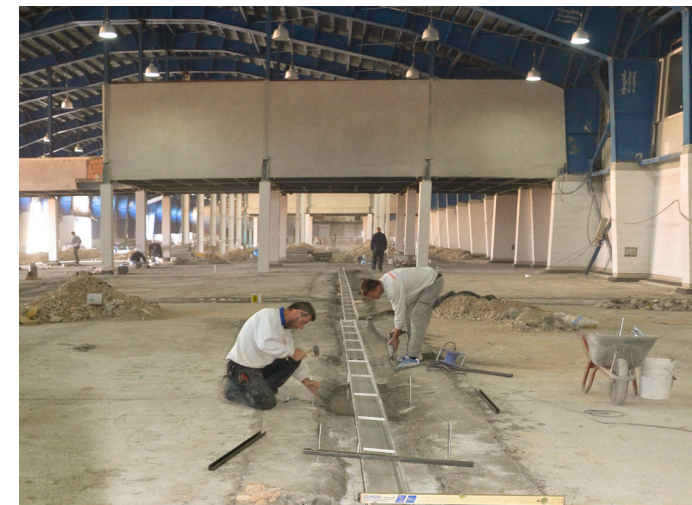
● اجرای شبکه انتقال پساب صنعتی سالن تولید با همکاری شرکت VIBROFLO آلمان
