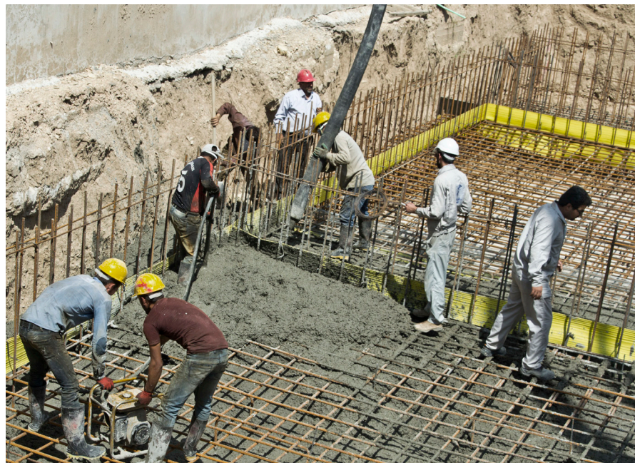
● اجرای مخزن بتنی ذخیره آب به حجم ۸۰۰ متر مکعب
