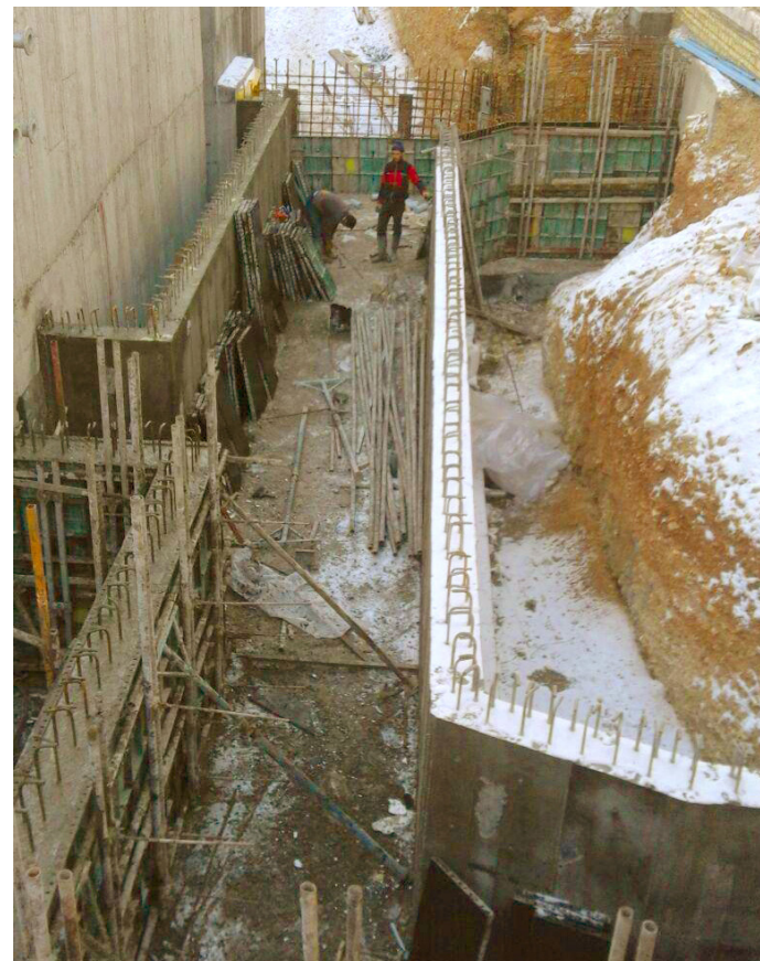
● اجرای سازه مدفون بتنی دیزل پمپ و کرپدور بتنی ارتباطی به علاوه نصب و راهاندازی تاسیسات مکانیکی آن
