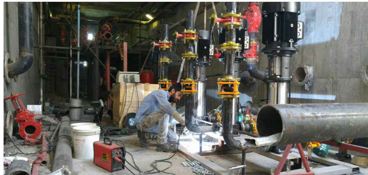
● اجرای سازه مدفون بتنی دیزل پمپ و کرپدور بتنی ارتباطی به علاوه نصب و راهاندازی تاسیسات مکانیکی آن
