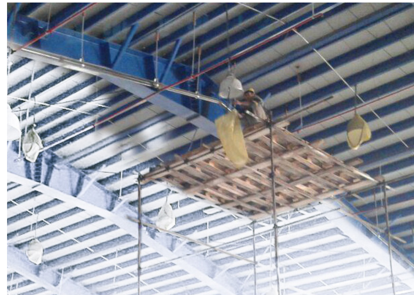
● اجرای پوشش اپوکسی پلی آمید سوله‌های تولید و انبارها به مساحت ۲۰,۰۰۰ متر مربع
