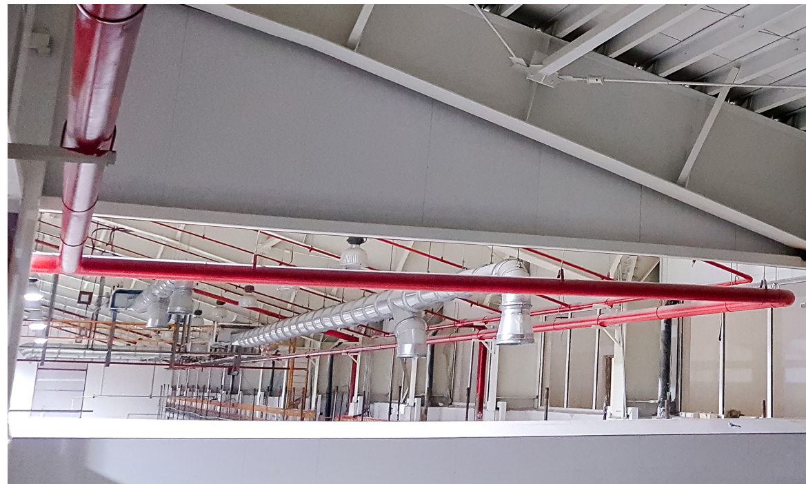
● اجرای سیستم اطفای حریق کلیه فضاهای کارخانه
