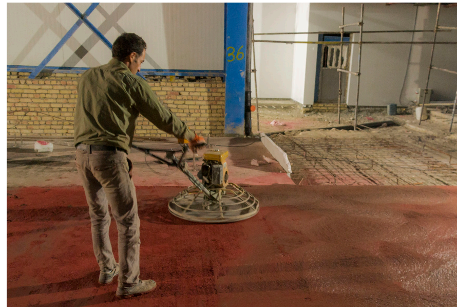
● اجرای بتن لیسهای سالن تولید
