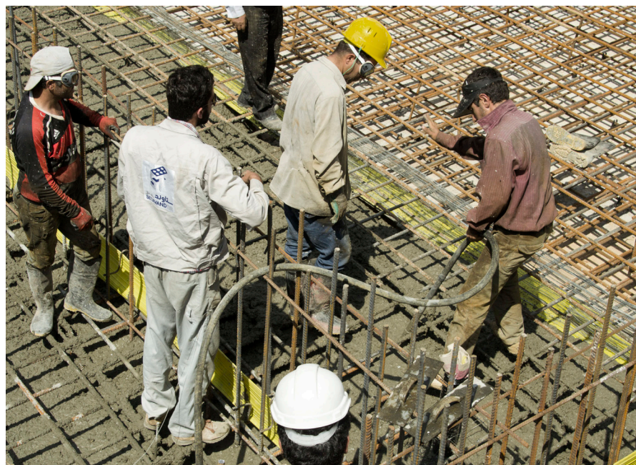
● اجرای مخزن بتنی ذخیره آب به حجم ۸۰۰ متر مکعب
