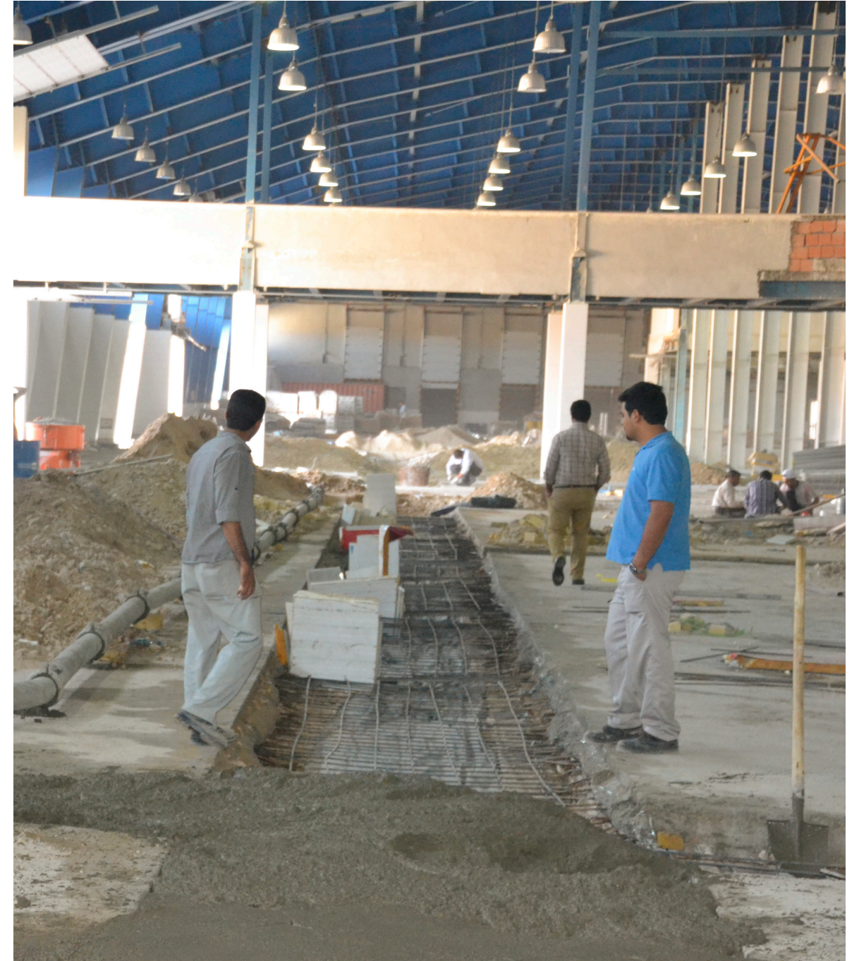
● اجرای شبکه انتقال پساب صنعتی سالن تولید با همکاری شرکت VIBROFLO آلمان
