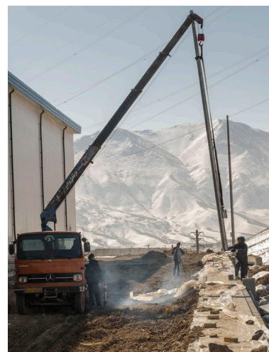
● اجرای محوطه‌سازی و جوی و پیاده رو، نصب تیرهای روشنایی
