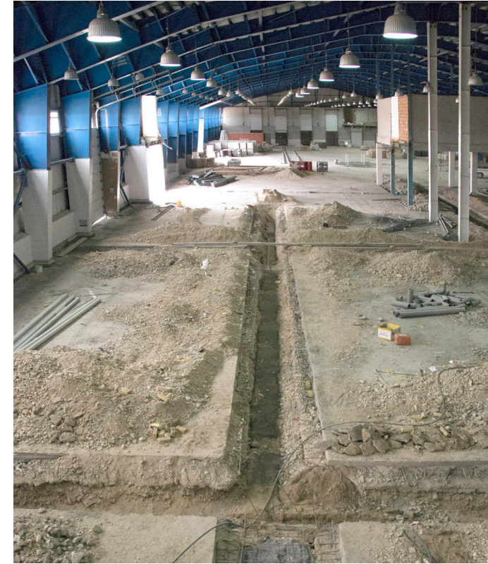
● اجرای شبکه انتقال پساب صنعتی سالن تولید با همکاری شرکت VIBROFLO آلمان
